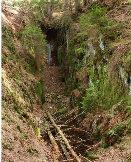
▲ Velmi výrazný relikt zasutého ústí štol, štolá Anna.
